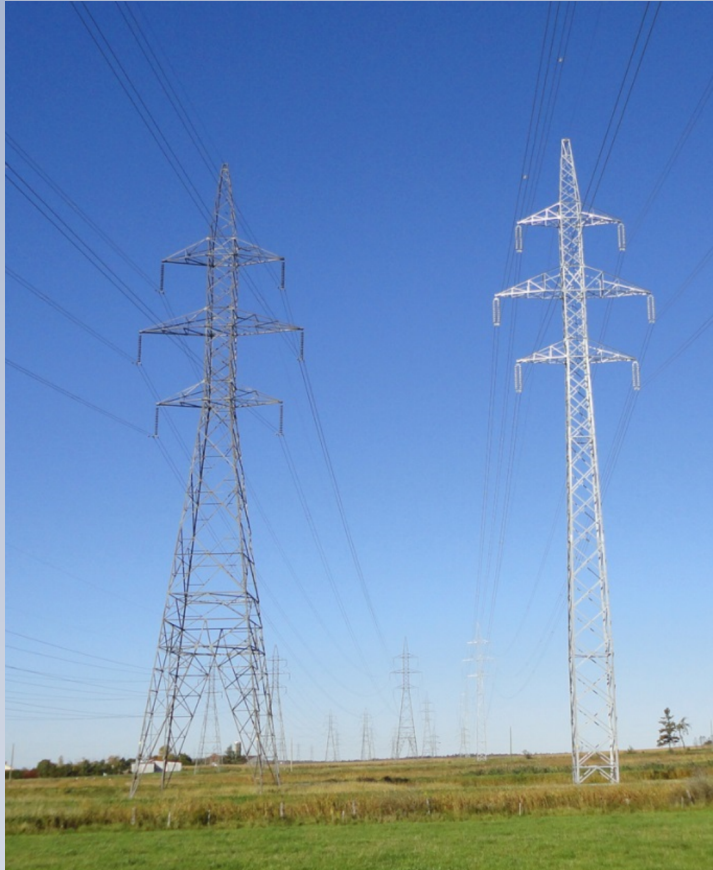
Pylône à empattement réduit (option retenue) à côté d'un pylône à empattement régulier
